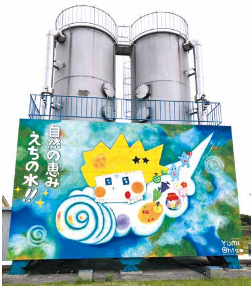
巨大壁画が水道事務所のトレードマークにもなっている脱炭酸塔
