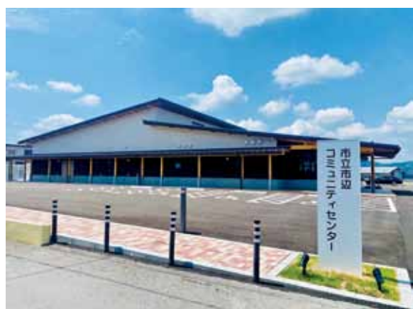
完成した市辺コミュニティセンター
