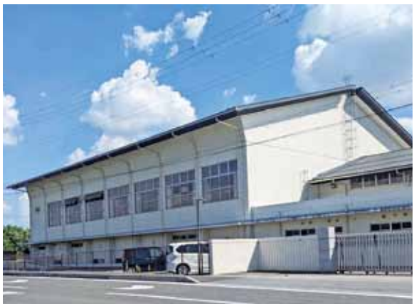
空調整備が予定される五個荘中学校体育館
