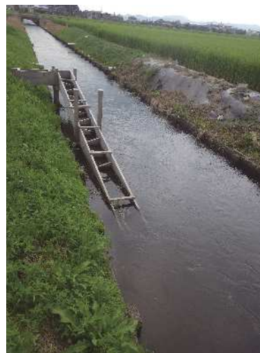
写真 25 水田の水路と魚道
