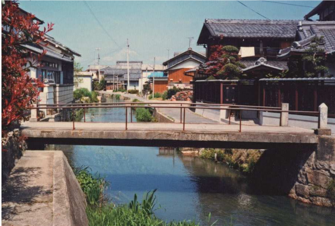
写真45 正厳寺橋と伊庭川(農業集落道整備前、福嶋崇雄氏撮影)
