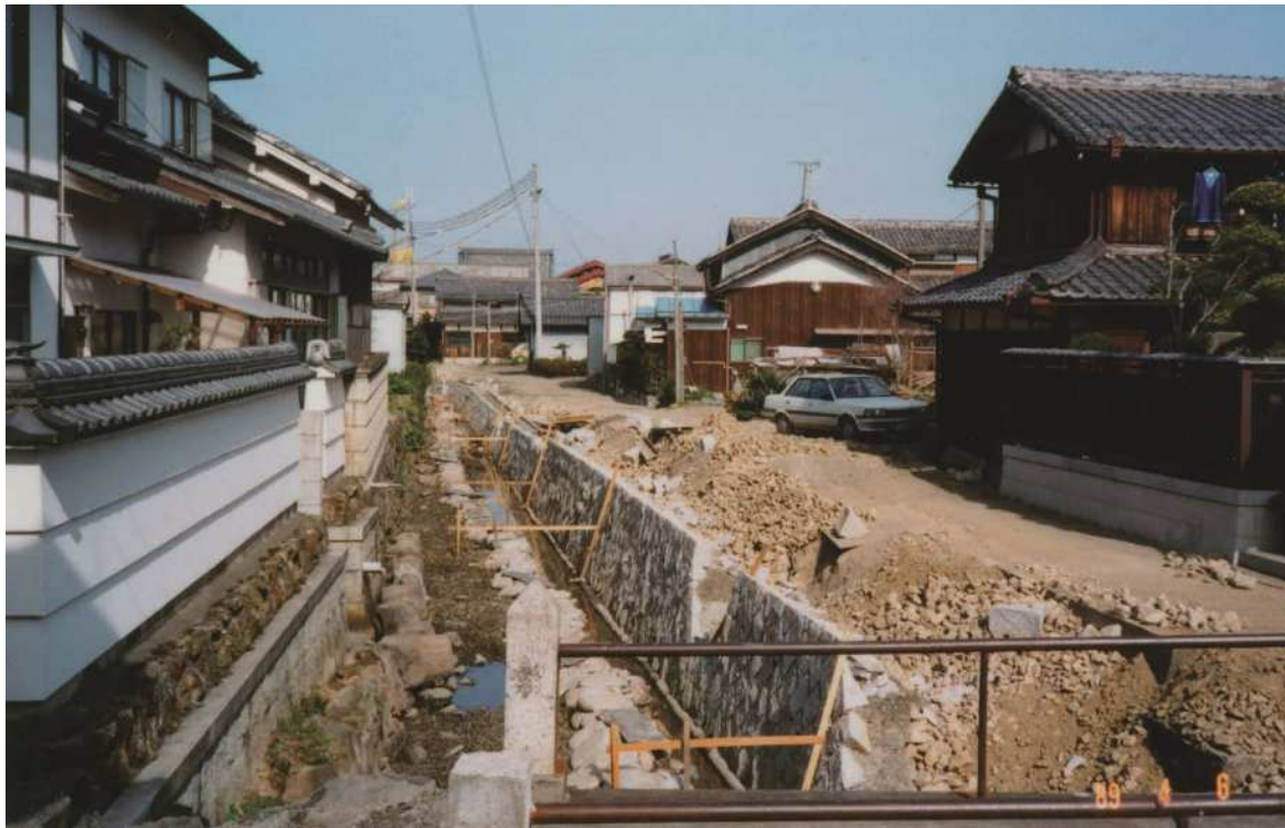
写真46 伊庭川の道路拡幅工事(福嶋崇雄氏撮影、1989年4月)
