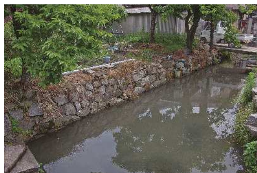
㉚集落内水路の石垣(東殿)
