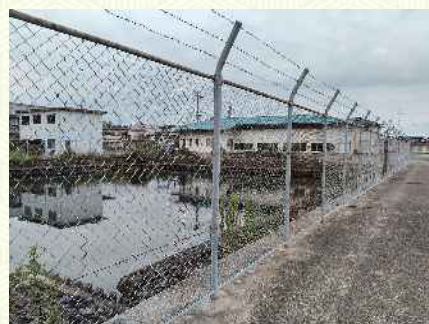
日吉揚水機場
