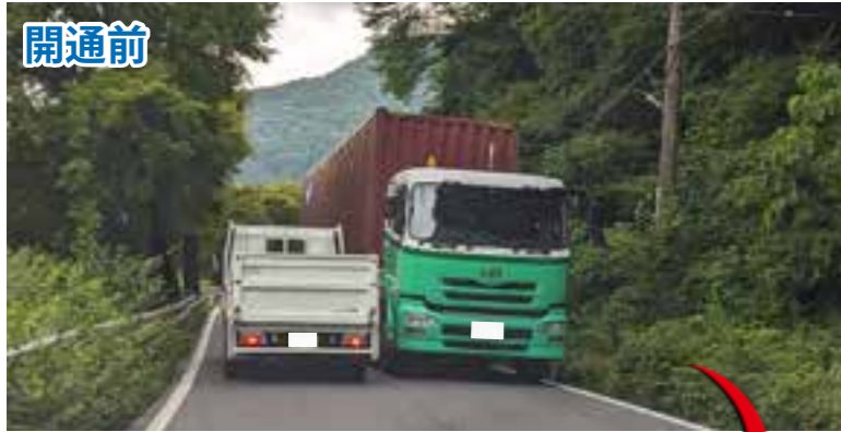
▲幅員が狭く、対向が困難な旧道
