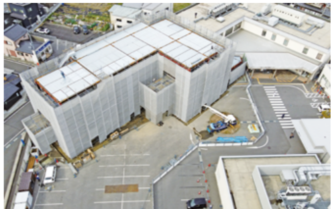
現在建設中の蒲生医療センター
