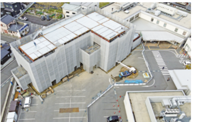
現在建設中の蒲生医療センター
