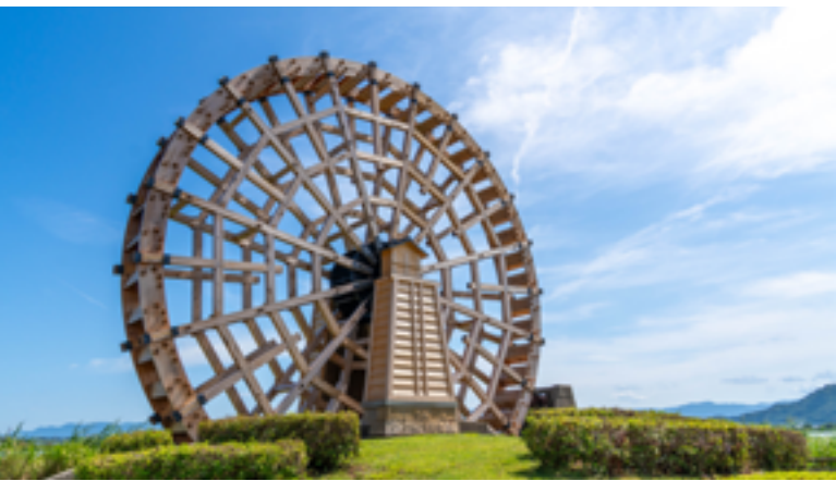
▲老朽化により稼働停止していた水車や屋外トイレ、水車資料館をリニューアル（能登川水車とカヌーランド）
