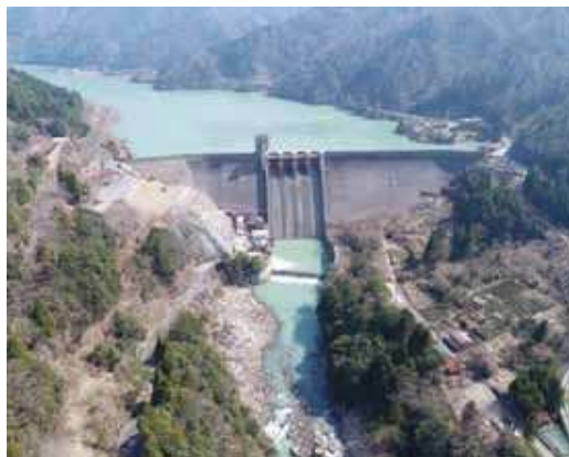
洪水予測による事前放流が始まった永源寺ダム
