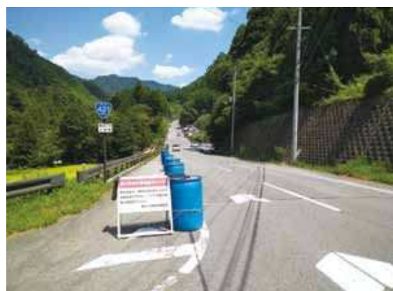
設置されたクッションドラム
