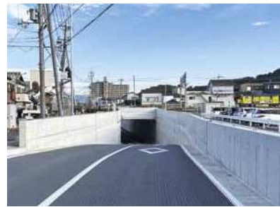
市内にあるアンダーパス(垣見隧道)
