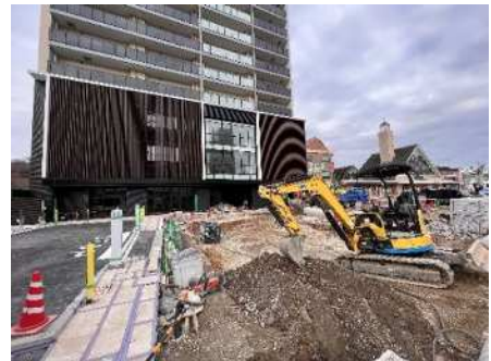
建設中の観光交流施設
