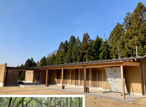
▲本市と日野町の境に「布引の森」を整備しました。
