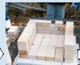
耐火レンガを積んでいきます。奥に空気穴を確保。
