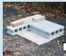
耐火シートの上に、コンクリートブロックを並べます。
