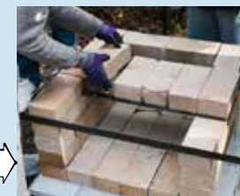
鉄アングルの置いて、さらに耐火レンガを積んでいきます。
