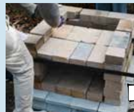
ピザを置く台が完成。さらに縁に耐火レンガを重ねます。
